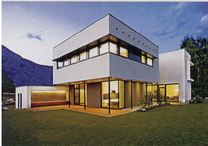
Ebenfalls von Annick und Jürgen Melis stammt das Passivhaus in Oberhofen. Eine Heizung ist dank Komfortlüftung obsolet.
