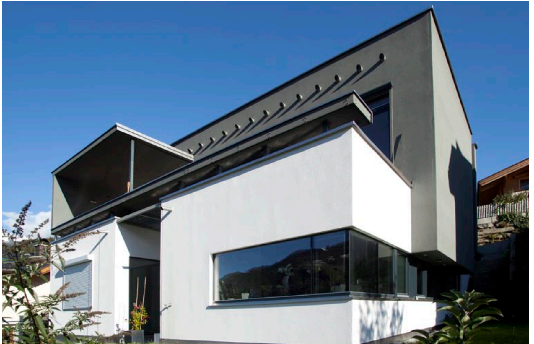
Die Westseite des Hauses mit der Terrasse im Obergeschoß. Eine Sitzbank zieht sich über die gesamte Breite und geht an einem Ende in eine Überdachung über.
